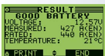
Test av 1-2 batterier
